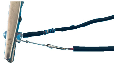
Abb. 15: An die LED gelötete Kabel
